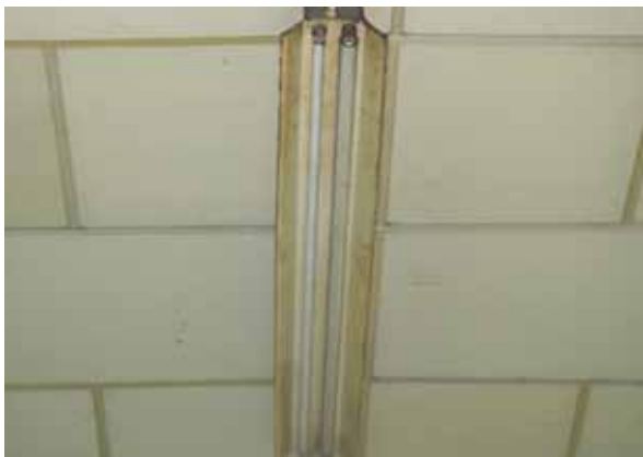
Figura 4 – Luminária equipada com fluorescente T8 e T12
