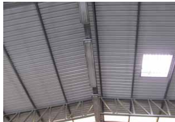
Figura 5 – Luminária equipada com lâmpadas fluorescente T5
