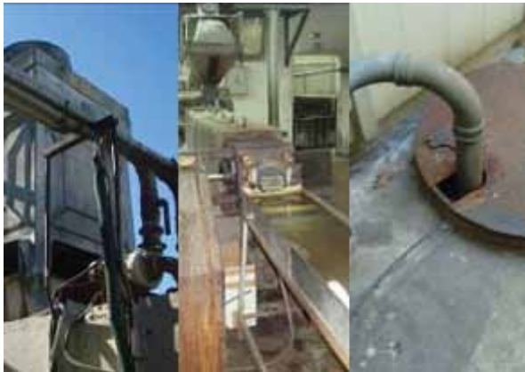
Figura 17 – Torre de arrefecimento, extrusora, depósito subterrâneo
