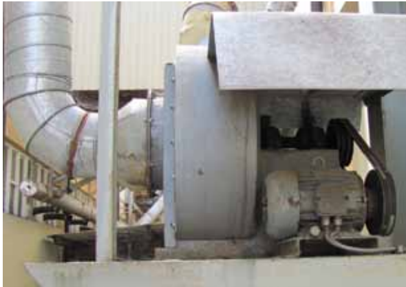
Figura 10 – Ventilador accionado por correias trapezoidais
