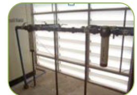
Figura 70 – Circuito de ar comprimido
