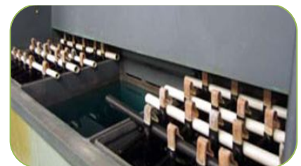
Figura 55 - Cabine de limpeza de bastidores
