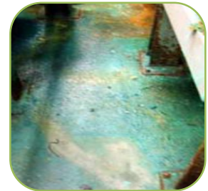
Figura 44 - Restos de pingos provenientes de banhos de níquel
