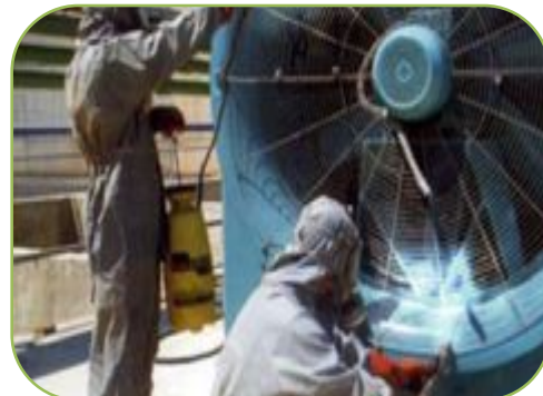
Figura 36 - Operações de desinfecção de uma torre de refrigeração
