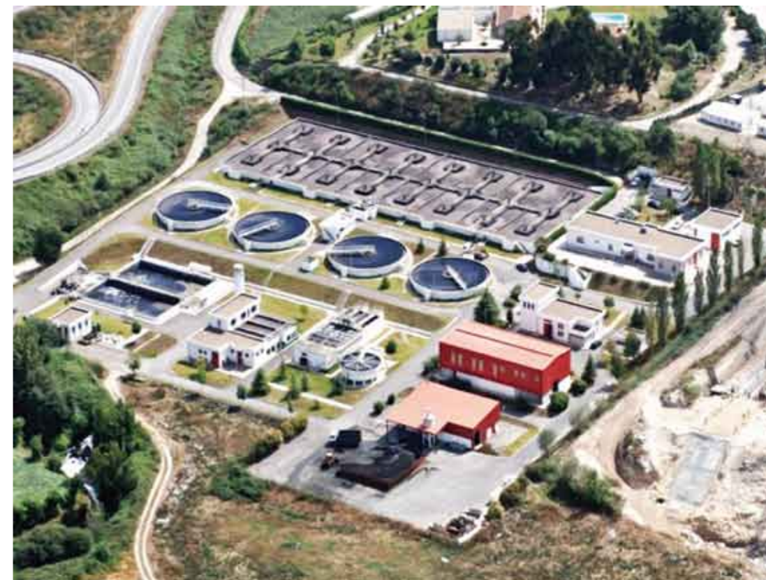
Figura 20 - Intervenção da Águas do Ave
