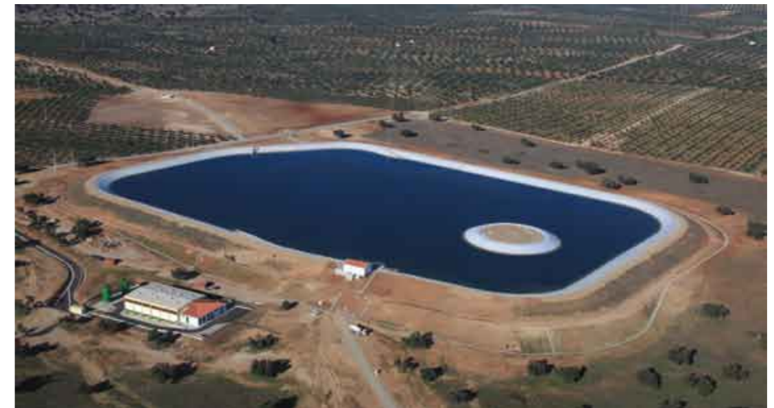
Figura 24 - Intervenção Adutor Brinches-Enxoé
