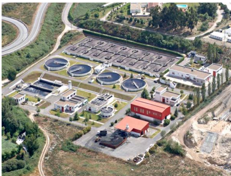
Figura 12 – Intervenção da Águas do Ave
