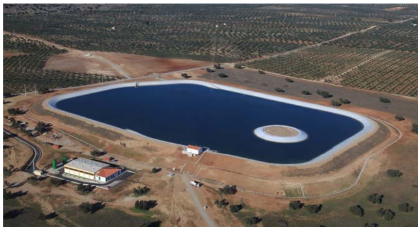
Figura 16 – Intervenção Adutor Brinches-Enxoé
